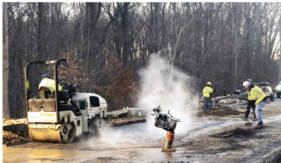
Centenares de operarios trabajan en la remoción de troncos de árboles caídos durante la tormenta y otros escombros, en la George Washington Memorial Parkway, en Arlington, luego de la tormenta del sábado que afectó toda la región de Washington. FOTO: CORTESÍA
