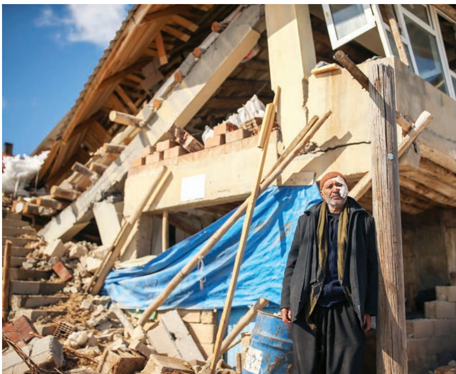
Un hombre herido junto a su casa derrumbada en la aldea de Buyuknacar, en Kahramanmaraş, Turquía, el miércoles 15 de febrero. Muchas de las decenas de miles de sobrevivientes que quedaron sin hogar luchan por encontrar refugio del frío intenso que llega a 4 grados Celsius bajo cero.
