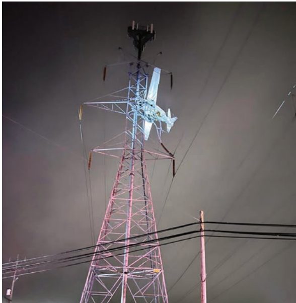
La avioneta aparece muy pequeña, incrustada en lo alto de una torre de transmisión de energía y a unos 30 metros de la superficie, en Gaithersburg. El choque provocó el corte masivo de electricidad en una vasta área del condado de Montgomery. FOTO: PETE PIRINGER-MONTGOMERY COUNTY FIRE AND RESCUE / AP
