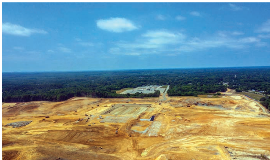
Sobre este enorme terreno se levantarán las instalaciones correspondientes a la ampliación de la nueva planta Toyota Battery Manufacturing de Carolina del Norte (TBMNC), cuya producción masiva se iniciará dentro de tres años.
