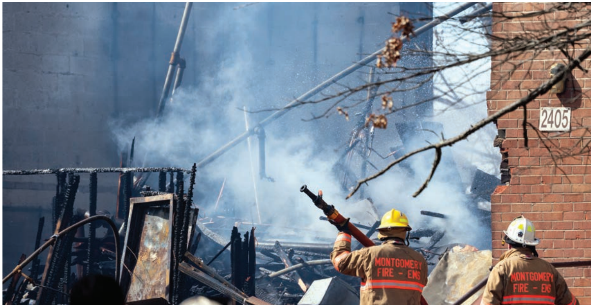
Bomberos se aproximan al mediodía del jueves a uno de los edificios colapsados de Friendly Garden, en Silver Spring, buscando a las víctimas atrapadas entre los escombros.
