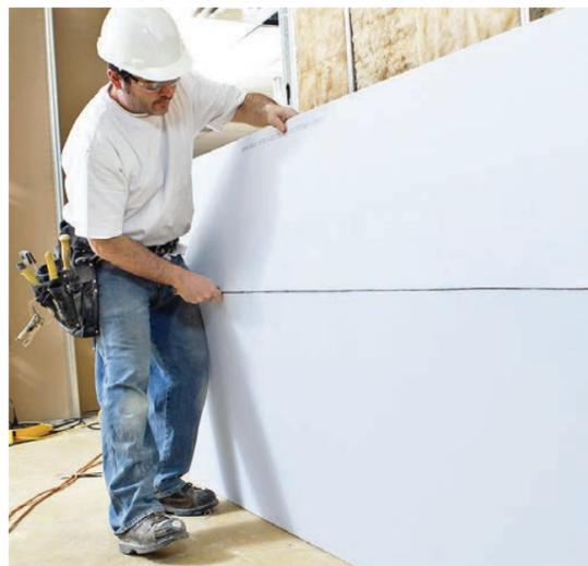
Los paneles de yeso diseñado para amortiguar el ruido y evitar que el sonido se expanda de una habitación a otra habitación.
