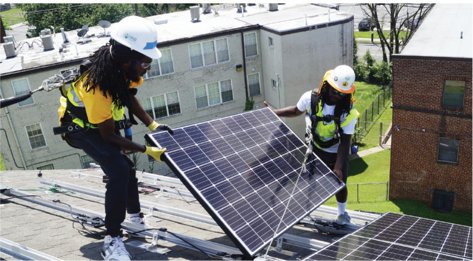
Solar Works DC ha instalado 100 sistemas de paneles solares en residencias de familias con bajo y mediano ingreso. FOTO: CORTESÍA.
