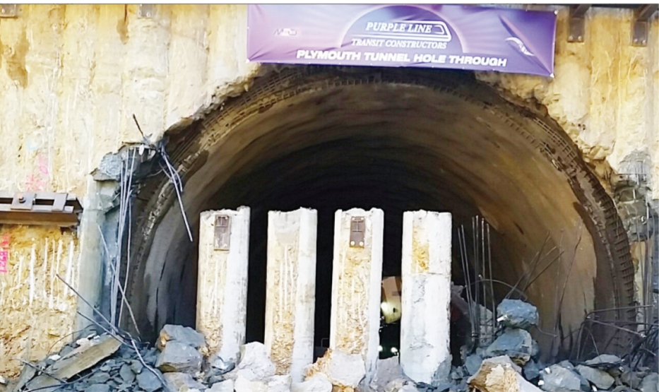
La futura estación en Silver Spring recibirá el nombre de Manchester Place. La excavación culminó con mes y medio de anticipación.
