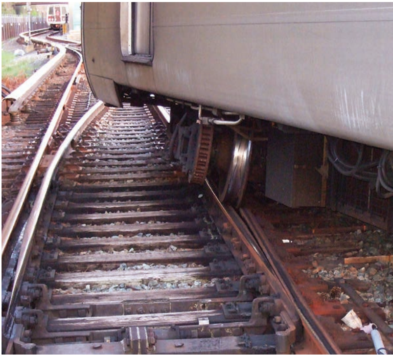
El cuarto y quinto vagón de un tren se salieron de su cauce por fallas en los rieles que los inspectores no reportaron. En total 21 personas han sido despedidas por esta falla. FOTO: CORTESÍA
