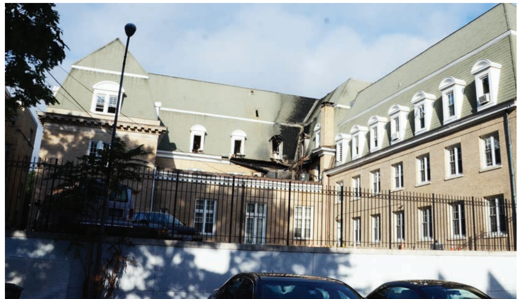
Las llamas salían del techo y fueron vistas por personal de emergencias médicas del Distrito de Columbia. El incendio afectó varias oficinas, incluyendo el Consulado y la representación Permanente de la OEA.
